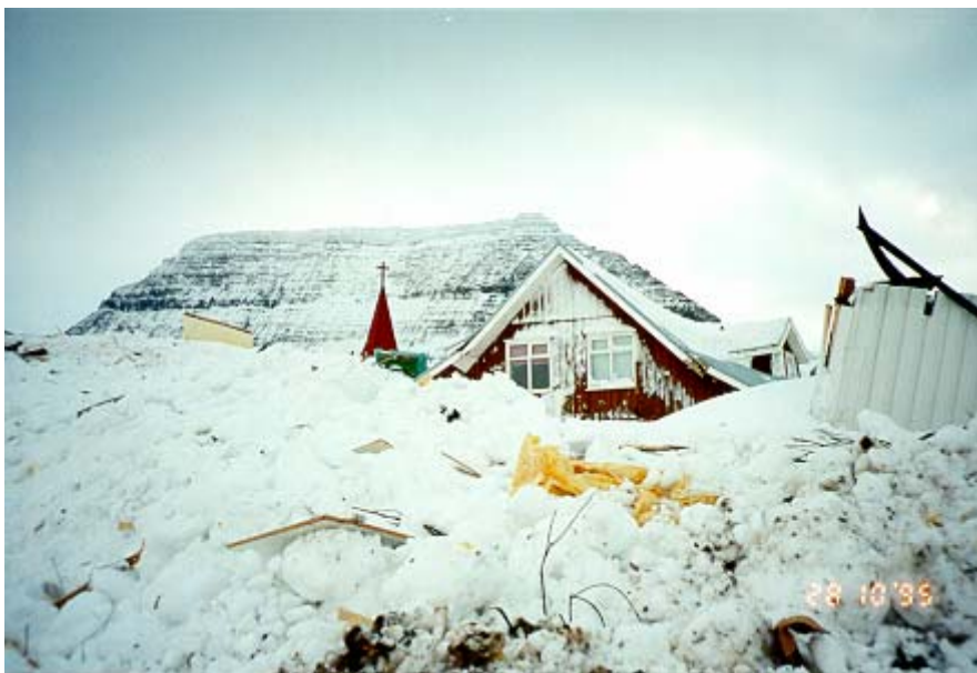
Mynd 14. Ris hússins fór með flóðinu. Fjölskylda var í risinu og sakaði ekki. (Ljósmynd: SHH).
