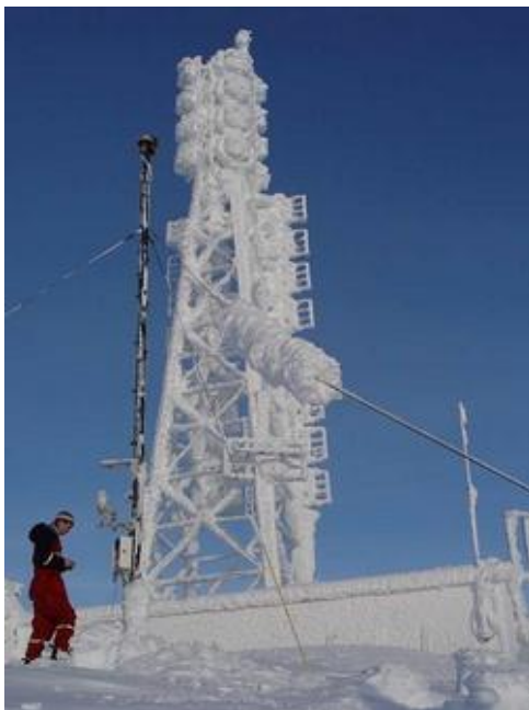
Mynd 8: Á Skálafelli í janúar 2005. Starfsmaður Veðurstofu Íslands er að ljúka við að berja ísingu utan af sjálfvirkri veðurstöð. Stórt ísþakið mastur í baksýn. Ljósmynd: Sigvaldi Árnason.
